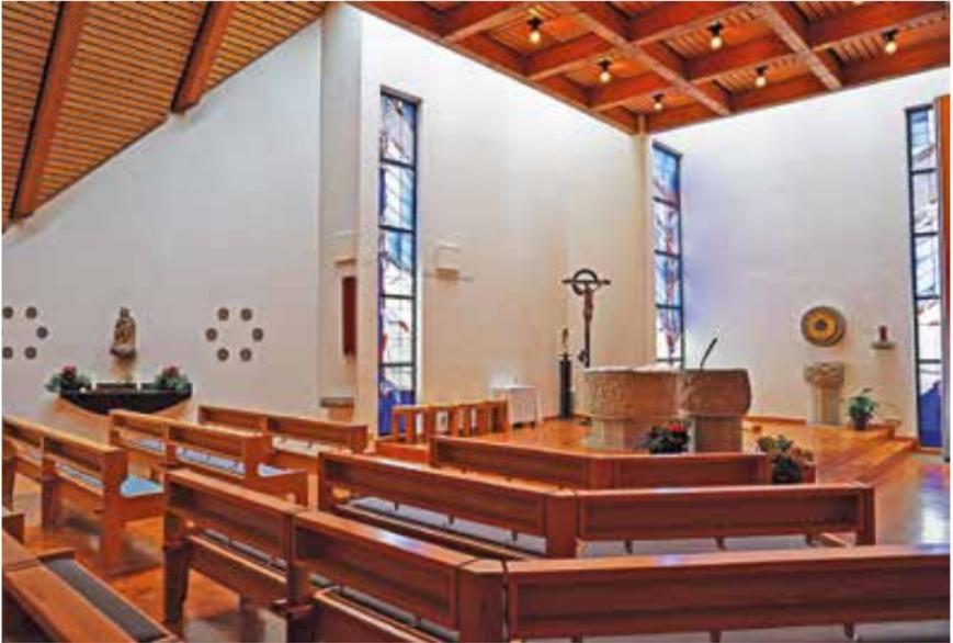
Mittelpunkt des Ökumenischen Zentrums ist der Sakralraum mit bis zu 250 Sitzplätzen. Der Boden ist mit Stirnholzpfaster belegt, das auch im gesamten Gemeindezentrum verlegt ist. Die Decke ist eine sichtbare Tragkonstruktion aus Leimbändern in Kassettenform mit Untersichtschalung. Die Wände und Stützen sind mit gefilztem Kalkzement verputzt und mit Mineralfarbe angestrichen.
