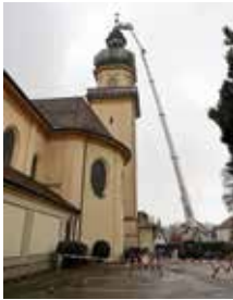
Der Salvatorturm wird renoviert
