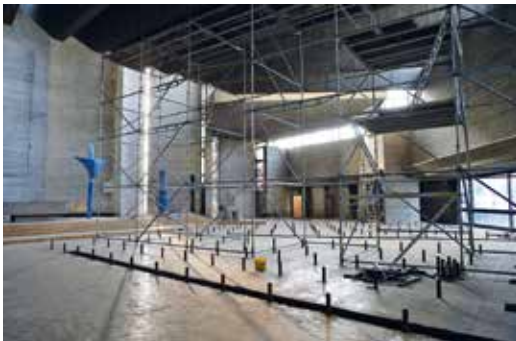
Die Großbaustelle in der Marienkirche
